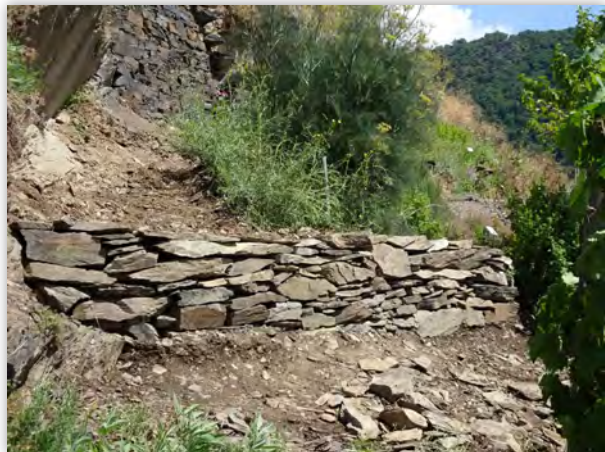
Neue Trockenmauer zur Kräuterbeeteinfassung.
