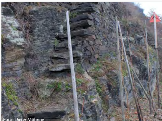
Weinbergmauer mit Scherentreppe in der Lehmener Würzlay
