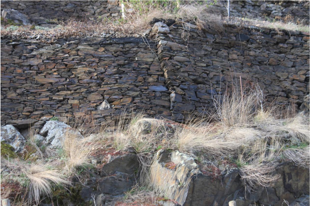
Trockenmauer gegründet auf Fels
