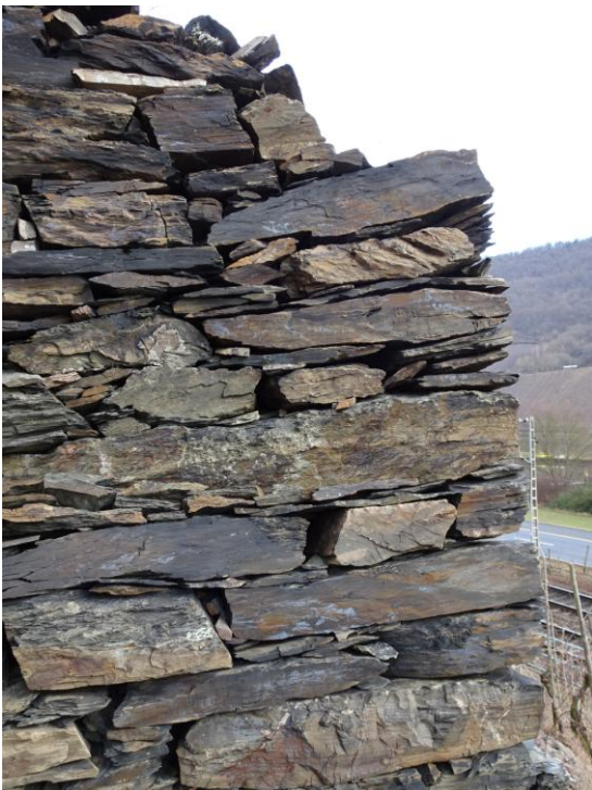
Foto links: Detail der Trockenmauer
